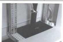
Legen Sie die 2-teilige Moosgummiabdeckung (erst hinten, dann vorn) in die Einspeisedurchführung ein. Die restlichen Öffnungen verschließen Sie mit den grauen Abdeckungen. (Einfach einlegen)
